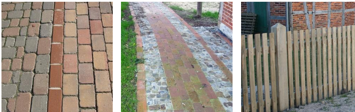
Abb. 22 Beispiele: gerumpeltes Betonrechteckpflaster, Naturstein/Klinker, Holz-Staketenzaun
