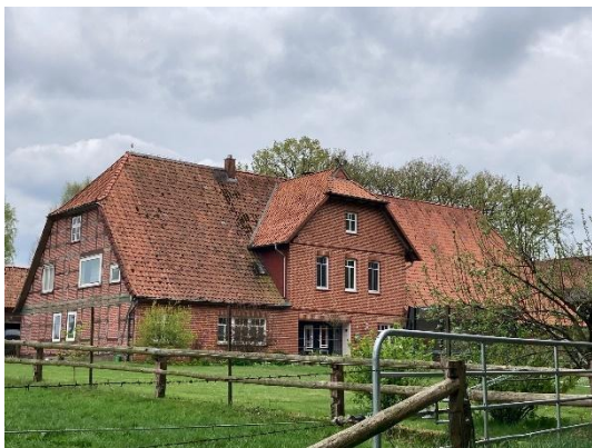
Abb. 1 Ortsbildprägendes Gebäude Kroge
