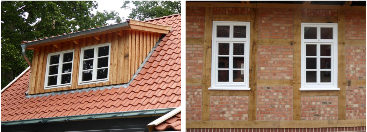
Abb. 9 Beispiele: Neue Dachgaube mit Fenstern und Holzverschalung, erneuerte Fachwerkfassade
