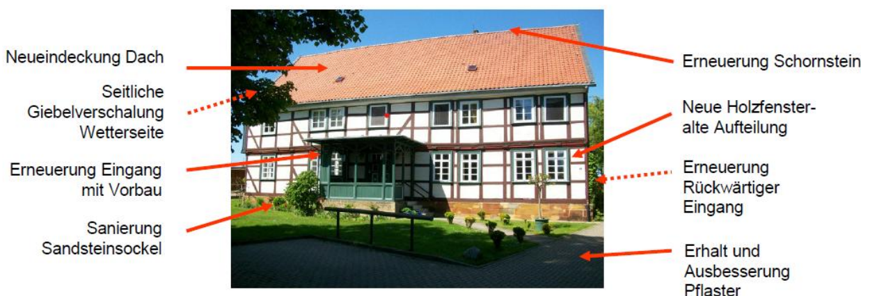
Abb. 3 Maßnahmen am Gebäude
