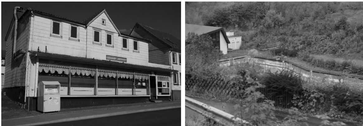
Abb. 14 Beispiel Leerstand und geschlossenes Freibad
