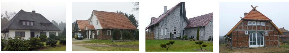
Abb. 41 Beispiele nichtförderfähiger Bausubstanz nach 1960 (Fotos außerhalb der Dorfregion)
