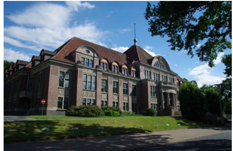
Altes Verwaltungsgebäude Wolff-Walsrode Bomlitz
